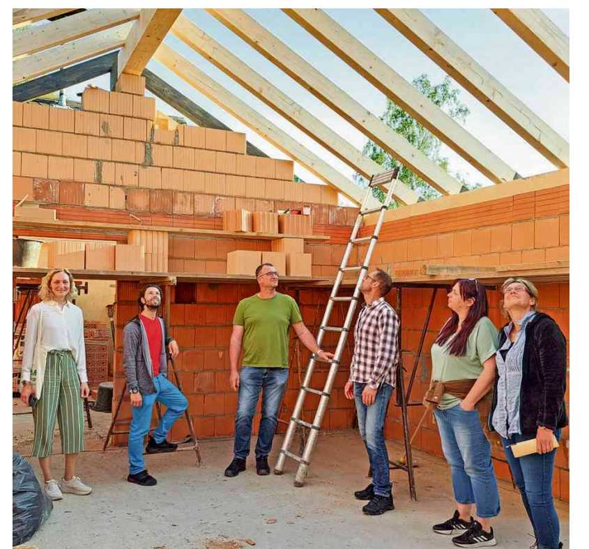
Das Dachgebälk soll sichtbar bleiben. Der Marktleuthener Bauausschuss verschaffte sich einen Eindruck vom Fortschritt im Dorfhaus Hebanz. Foto: Katrin Lyda
